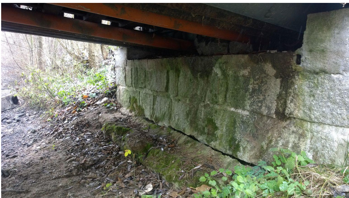
❑ obr. 8 - detail uložení na krajní podpěru
