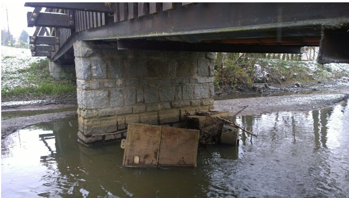
❑ obr. 7 - pohled na mezilehlou podpěru a železný odpad v korytě
