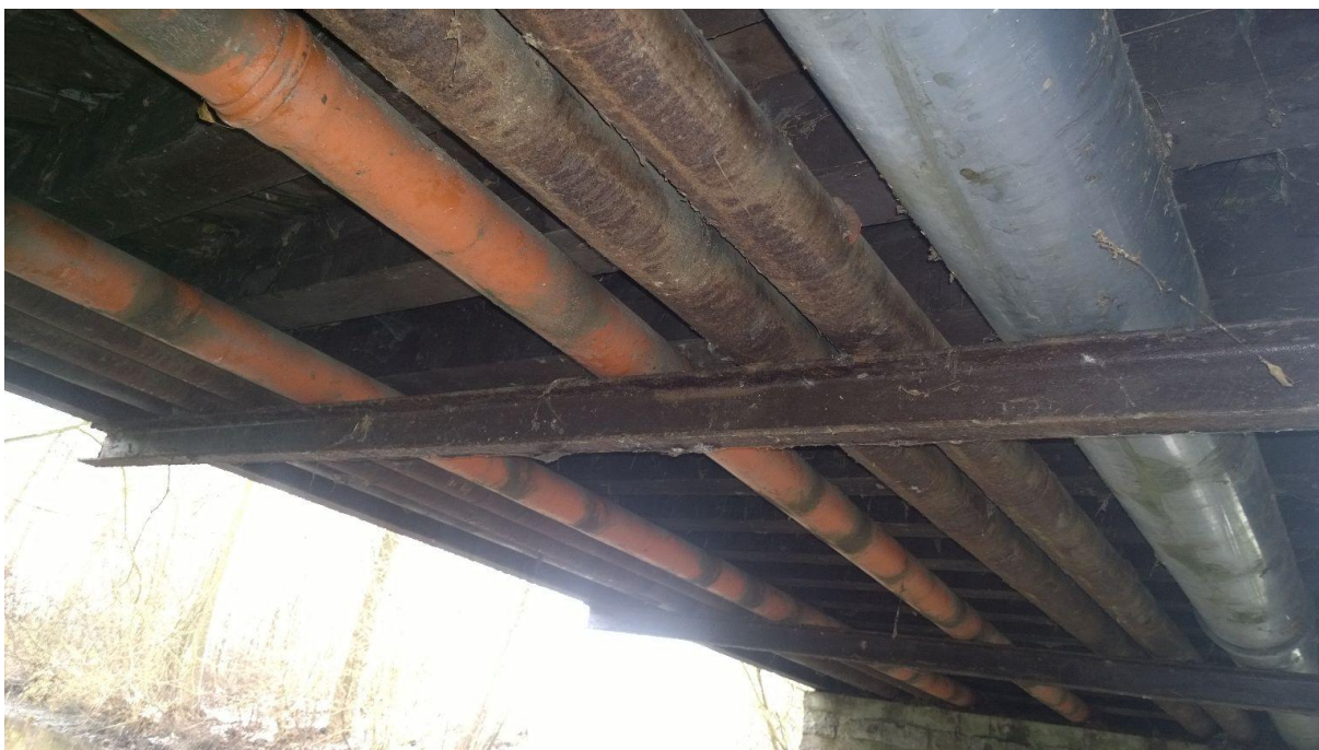
❑ obr. 5 - pohled mostovky a koroze chrániček
